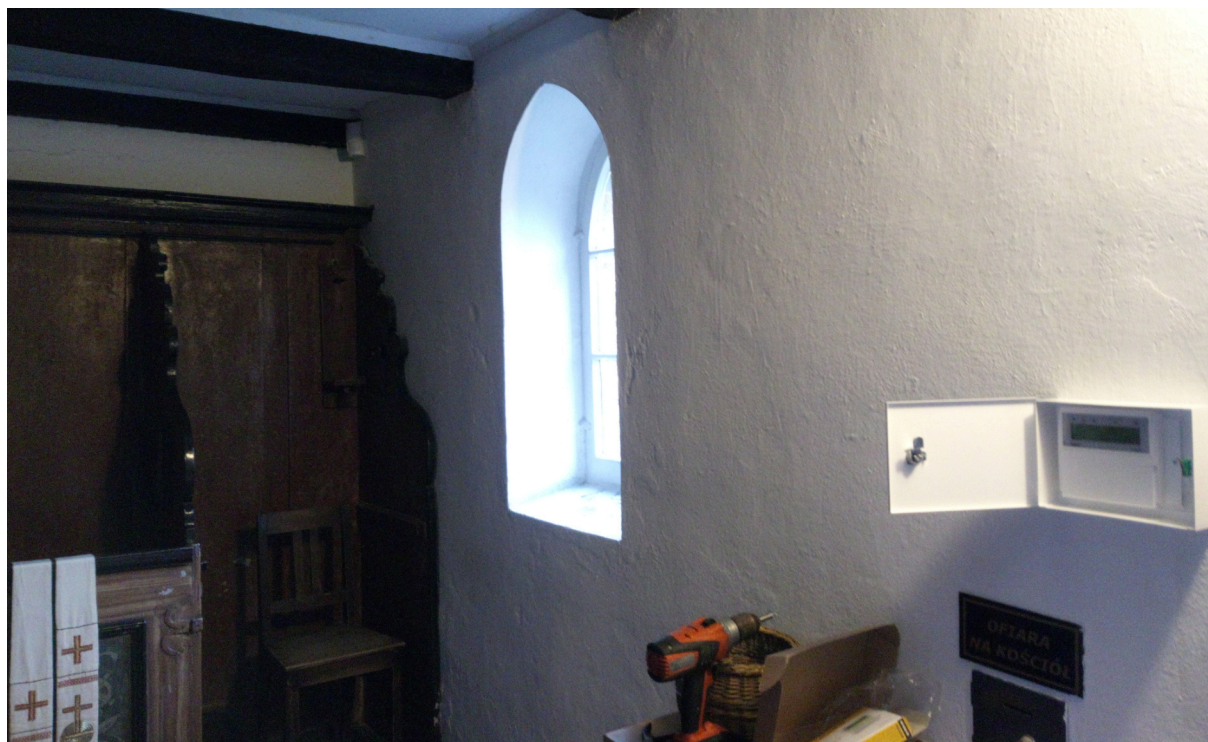
Foto. 1. Widok wnętrza kościoła w trakcie budowy strefy kontroli dostępu z wykorzystaniem czujki strefowej. Źródło: Krzysztof Urzędowski Beta Security System Sp. z o.o. Opole
